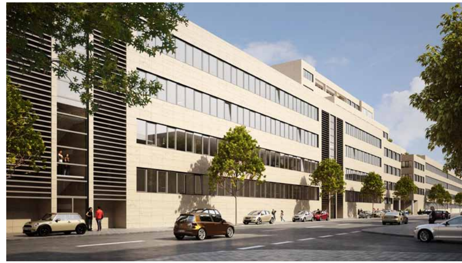
Ansicht Strassenseite (Duisburger Str.)
